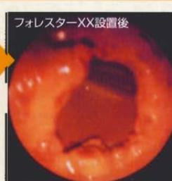
このようにフォレスターXXを設置する前の水道管は赤サビで配管が閉塞している。しかし、フォレスターXXを設置2ヶ年後には磁力線により鉄分を主とする有機物が沈殿した為、スケール・赤サビがかなり除去され、黒錆化の体積収縮がおこり、閉塞が改善されている。
