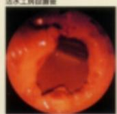
このように活工房を設置する前の水道管は赤サビで配管が閉塞している。しかし、活工房を設置2ヶ年後には磁力線により鉄分を主とする有機物が沈着した為、スケール・赤サビがかなり除去され、黒錆化の体積収縮がおこり、閉塞が改善されている。
